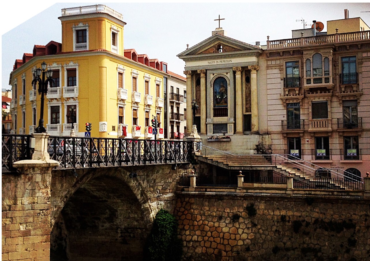
Puente Viejo o Puente de los Peligros
